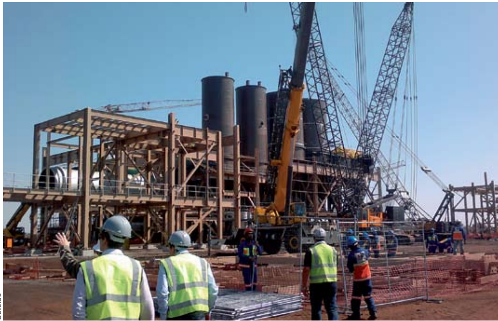
Mangaanimalmin sintrauslaitos nousee Etelä-Afrikan Kapmaahan. Keväällä 2012 käynnistyvä laitos tuottaa sintteriä runsashiilisen ferromangaanin tuotantoon.
