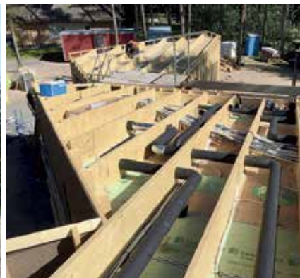
CLT-elementtejä nostetaan paikoilleen. | Talon runko on jo hahmollaan. | Ilmanvaihtokanavat piiloutuvat kattorakenteisiin.
