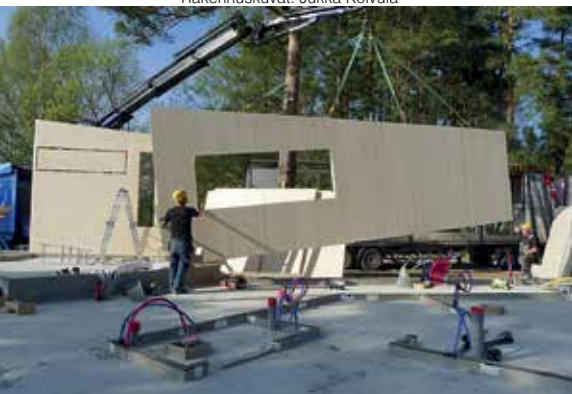
CLT-elementtejä nostetaan paikoilleen. | Talon runko on jo hahmollaan. | Ilmanvaihtokanavat piiloutuvat kattorakenteisiin.
